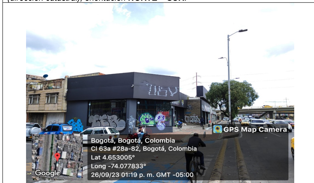
Foto 4. Vista panorámica del lugar donde se encontraba instalado el elemento en la Av. Carrera 30 No. 63 - 68 (dirección catastral), orientación NORTE – SUR , donde se evidencia que fue desmontado.
